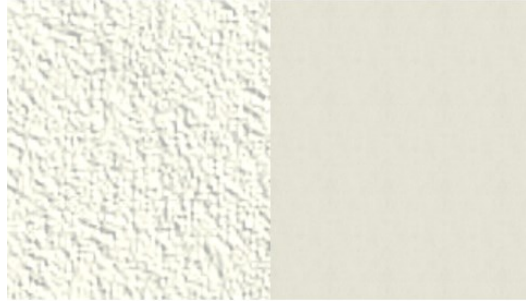
Figura 26. Aparência do reboco exterior (esq.) e reboco interior (dir.).
